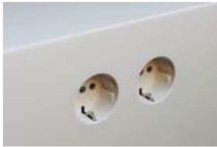
Ein besonderes Highlight sind die eingelassenen Steckdosen. Die Anschlüsse wurden direkt in einzelne Hi-Macs-Elemente eingearbeitet (Detail-Fotos: Pirkelmann + Schmidt GbR)
